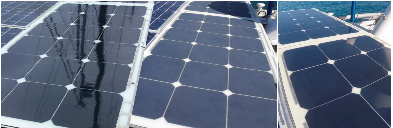
Nach der Installation
